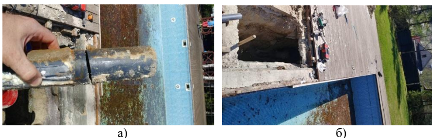
Рис.2 Застосування пневматичних заглушок (а) та комплексної методики з апаратурою додаванням повітря в трубопровід та використанням течешукача А-10ТЗ з експериментальним датчиком (б) дало змогу при малому надлишковому тиску в полімерних трубопроводах фільтрації басейнів успішно знаходити приховані витоки.
