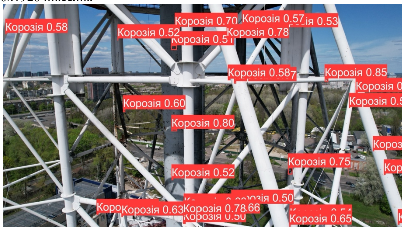
Рисунок 2 – Результат знаходження дефектів з допомогою ШІ. Червоним виділено - назва дефектів і їх ймовірність наявності.
