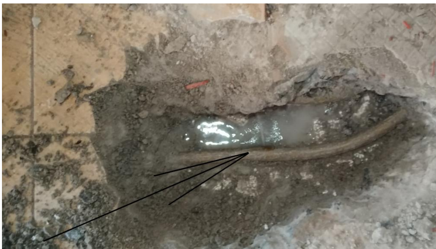
Рис.3. Демонтаж кахелю та місце витоку.
